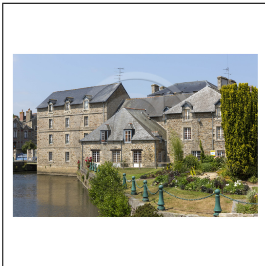
Les moulins du port de Plancoët ( 22 ).***Mills of Plancoët Harbor.
