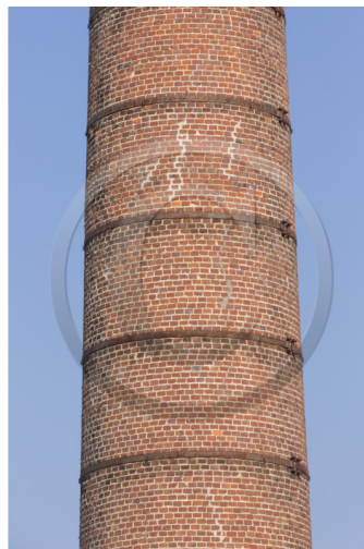
Cheminée en briques rouges de l' ancienne distillerie de Plancoët.***Red brick chimney of the former distillery_ Plancoët .
