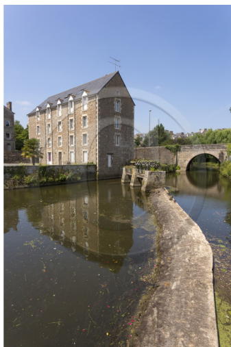
Les moulins du port de Plancoët ( 22 ).***Mills of Plancoët Harbor.
